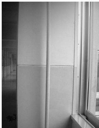
本校には左のように廊下の柱に沿って電気配線のパイプが縦に取り付けられています。このパイプはちょうど握れるほどに壁との間に隙間があるためか、よく引っ張られて曲がることがあります。その度に教頭先生が留め具の修理に工具を持って奔走します。
