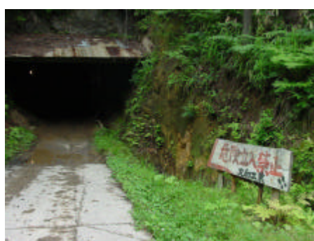
丸和工業・掘削トンネル (杉山)
