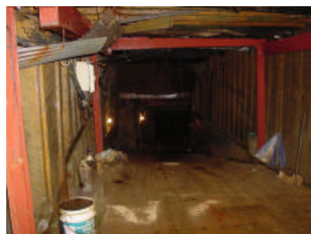
能登ダイヤ工業・トンネル内部
